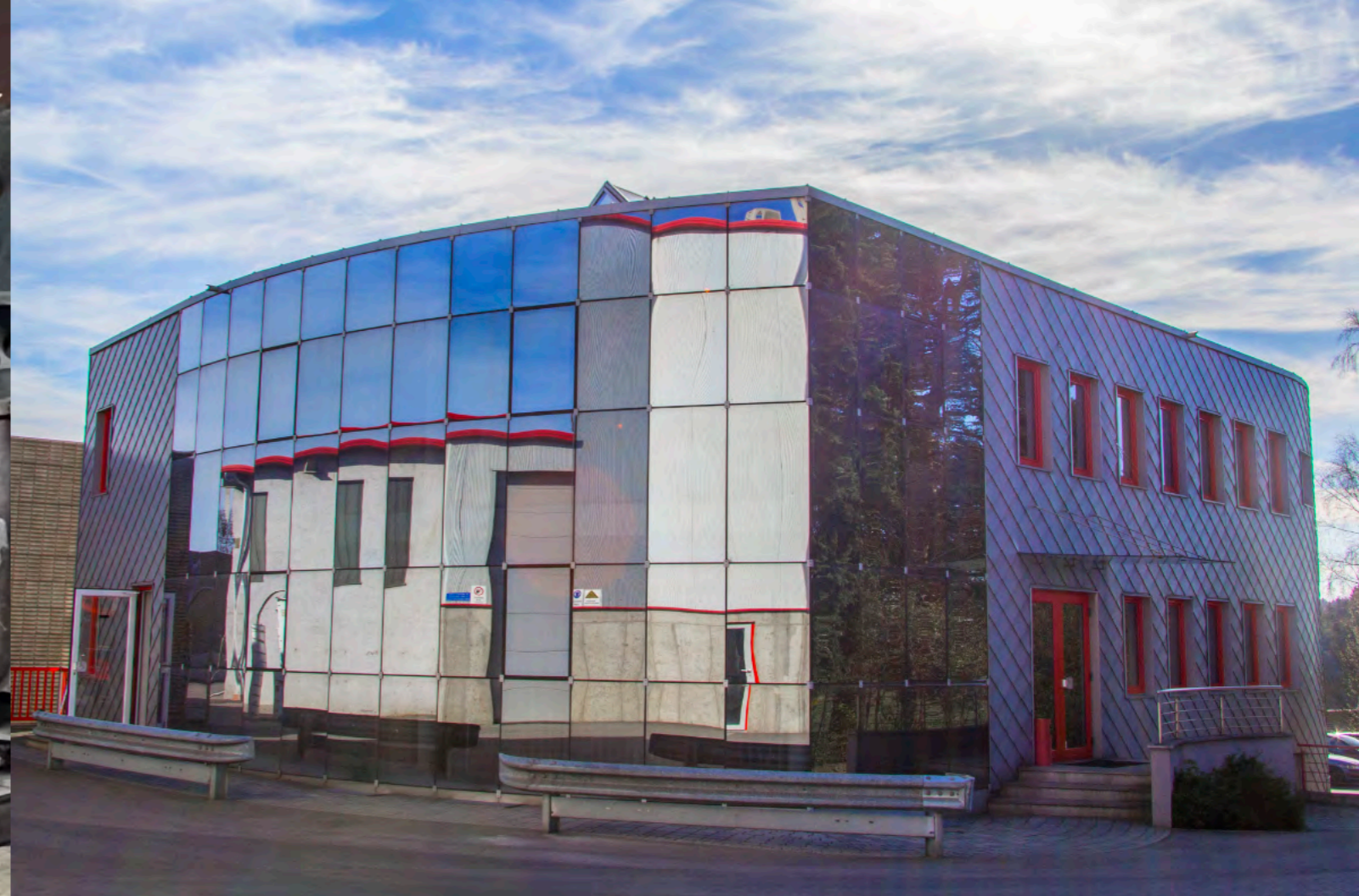
Bürogebäude der Hütte Klein-Reichenbach
